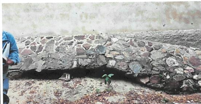
FOTO 5. REPARACION MURO DE CONTENCIÓN
