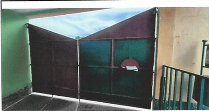
FOTO 3: SUSTITUCION DE PORTON PRINCIPAL
